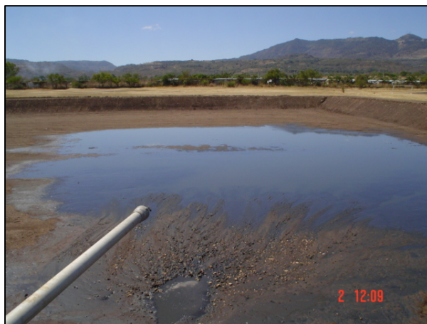
Figura 17– Lodos secándose en la laguna
