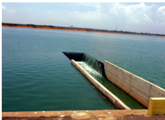
Figura 25. Salida del efluente tratado en la Planta Sur al lago Maracaibo
