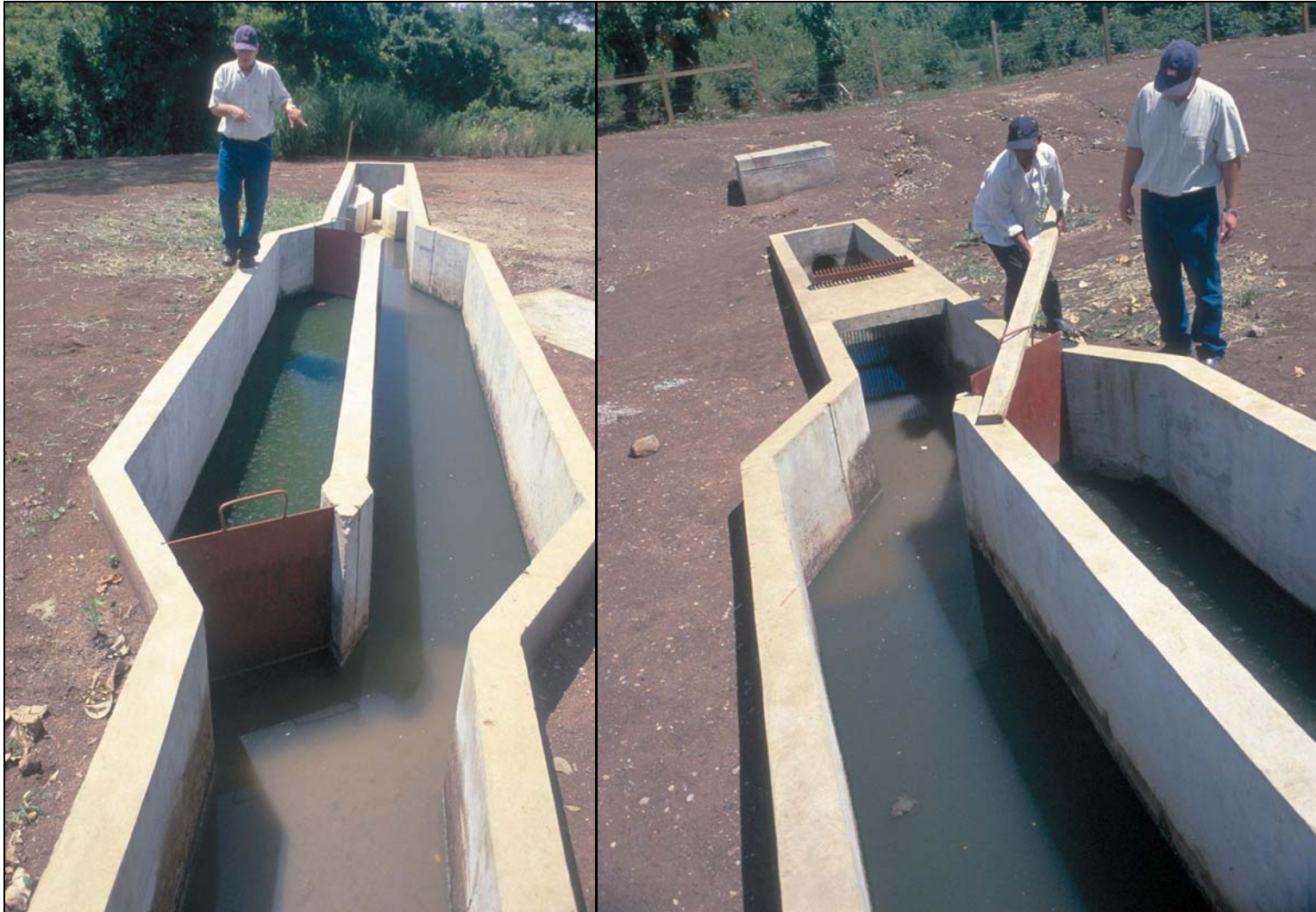
Fotos 5-6: Este desarenador no tenía drenaje y la cámara fuera de servicio (lado izquierdo) estaba llena con agua estancada con problemas de natas flotantes, malos olores, e insectos. El operador tenía que abrir la compuerta y utilizar el desarenador con las dos cámaras en servicio, una operación para la que no fue diseñado. Todos los desarenadores deben tener drenaje y compuertas que sellan bien (Santa Cruz de Yojoa, Honduras).
