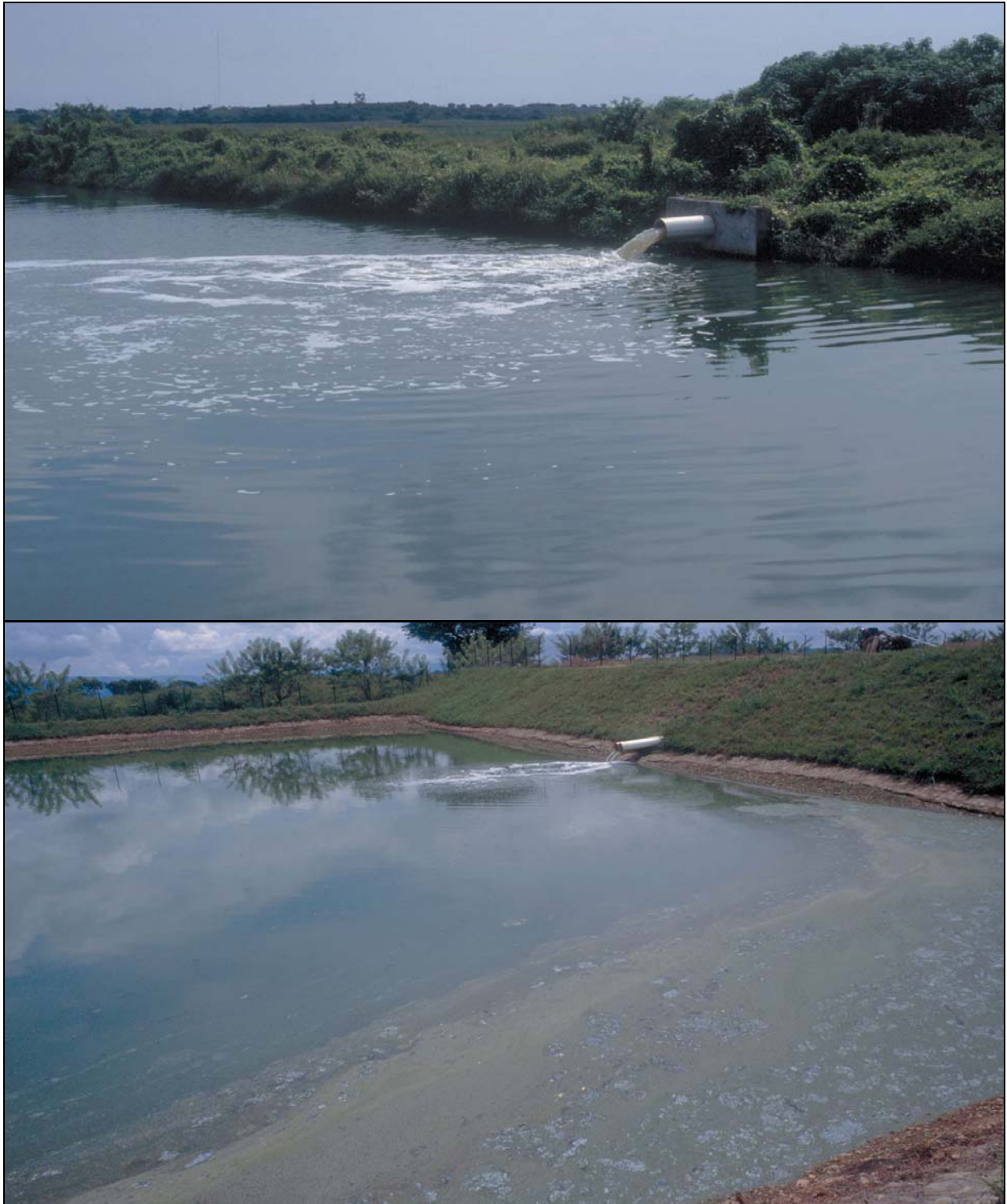
Fotos 5-8: Dispositivos de entrada con una simple entrada arriba de la superficie causan zonas muertas en las esquinas y turbulencia por la caída de agua que no promueve flujo de tipo pistón. Como resultado, las lagunas tienen cortos circuitos hidráulicos, lo que disminuye el volumen útil de la laguna y, entonces, su eficiencia de funcionamiento. Se debe diseñar dispositivos múltiples de entrada y salida en lagunas facultativas y dispositivos sencillos con mamparas desviadoras en lagunas de maduración (Foto arriba: Choluteca, Honduras. Foto abajo: Catacamas, Honduras).
