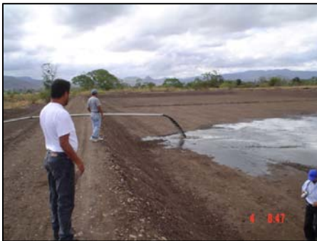
Figuras 15 – Lodos acuosos depositándose en la laguna de secado
