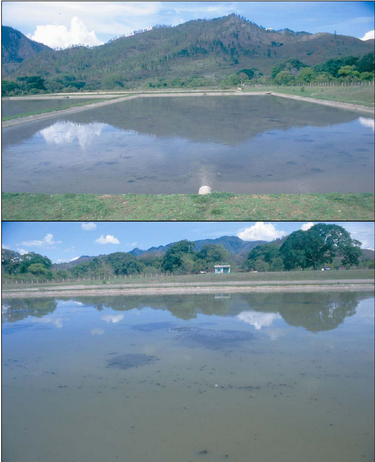
Fotos 3-2: Las lagunas anaeróbicas de Danlí, Honduras. Se ve claramente las burbujas llevando los lodos sedimentados a la superficie (los colores negros), que pueden también llevar los huevos de helmintos a la siguiente laguna. Estas lagunas están llenando con lodos y, por su profundidad, será difícil y costoso removerlos, un problema típico del uso de lagunas anaeróbicas.
