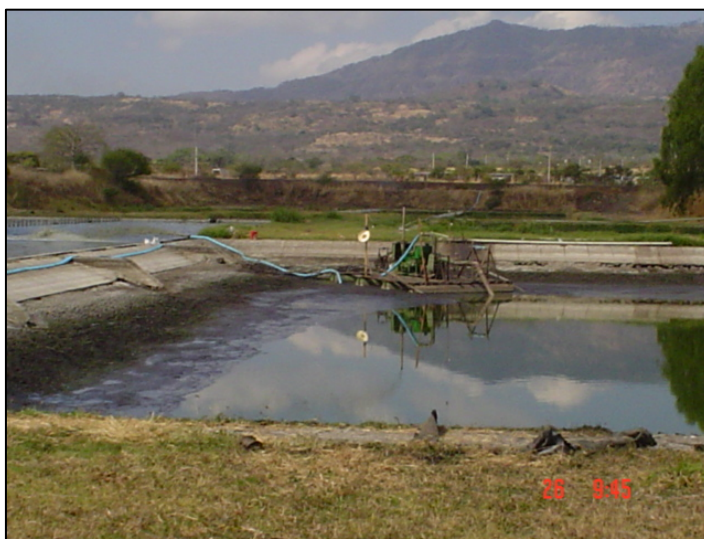
Figura 18– Reducción de nivel de agua en la laguna primaria “A”
