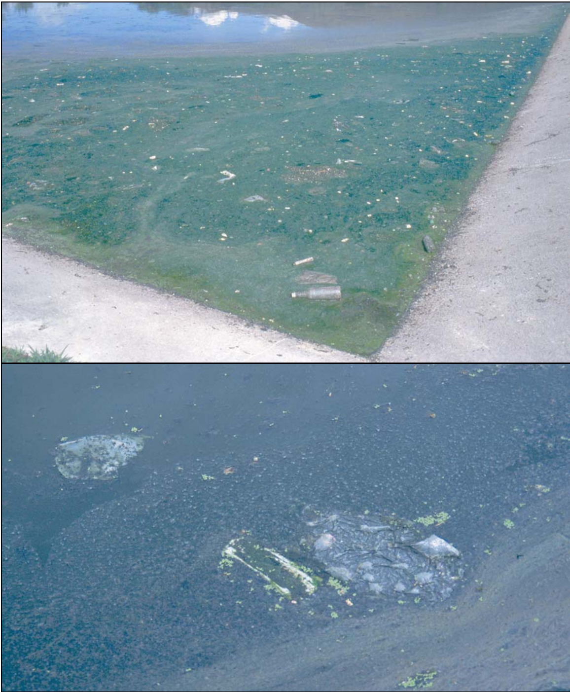
Fotos 1: Los sólidos flotantes y gruesos pueden causar problemas nocivos en la operación de las lagunas: ellos ayudan a la formación de nata que puede producir malos olores, sirven como un foco para la reproducción de insectos y producen condiciones desagradables a la vista. Deben ser removidos a través de rejillas en la entrada del sistema (Foto arriba: Danlí, Honduras; abajo: Morocelí, Honduras).
