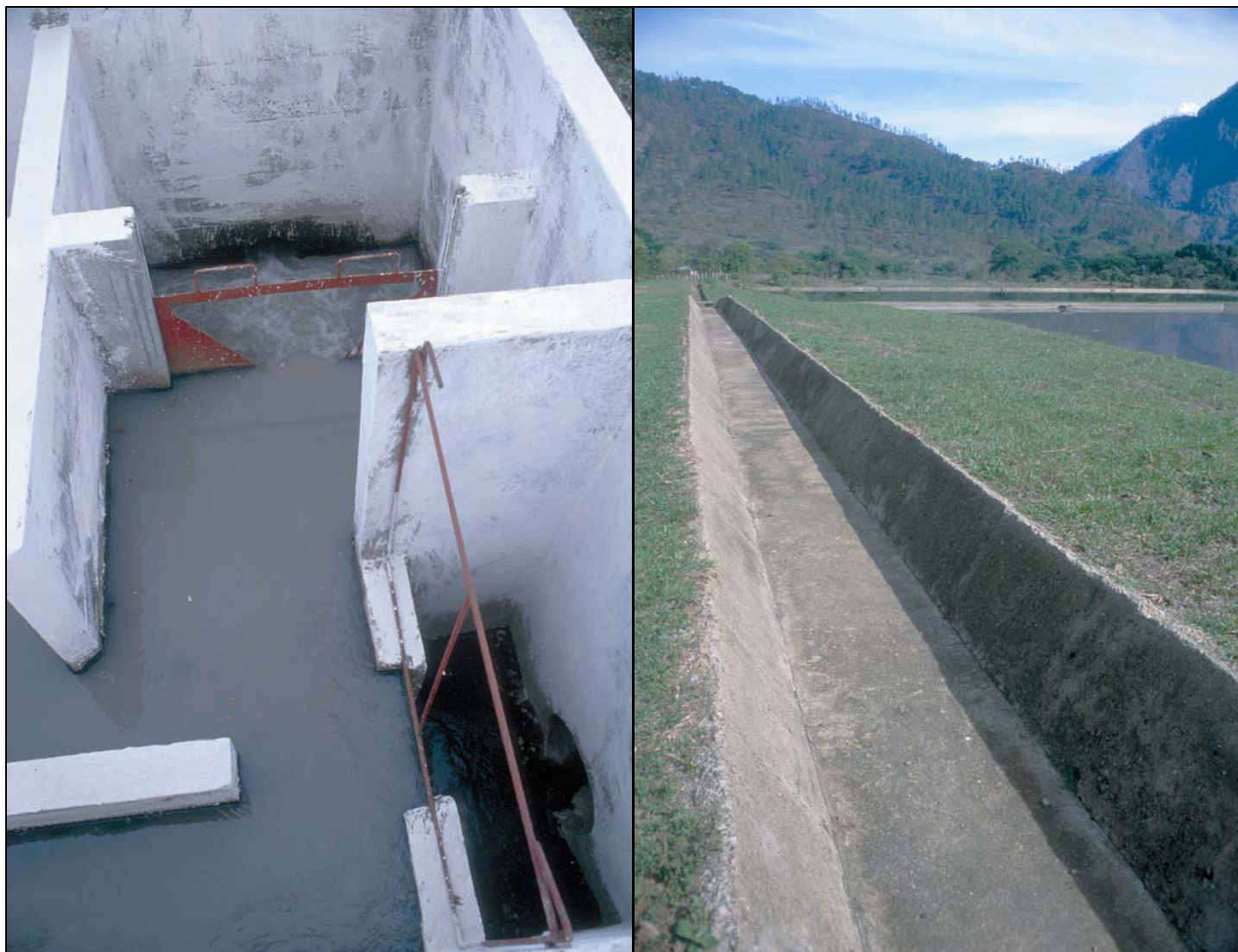
Fotos 5-17: Ejemplos de vertederos de demasías y canales de desvío para proteger el sistema de lagunas de sobrecargas durante tormentas. El vertedero a la izquierda es ajustable y el operador puede ajustarlo cuando sea necesario. Cuando el nivel del agua sube durante un caudal excesivo, un porcentaje del caudal es descargado al canal de desvío (Foto izquierda: Granada, Nicaragua. Foto derecha: Danlí, Honduras).
