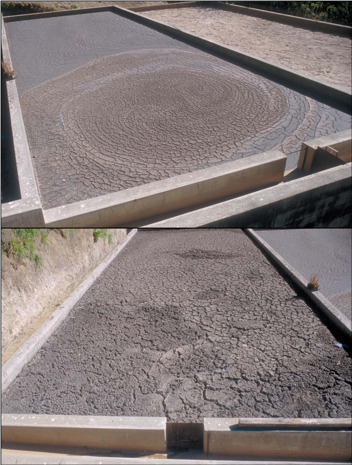
Fotos 7-2: En el lecho de secado, tal como se ve arriba, los lodos están frescos y acaban de empezar secando con una capa superior duro que impide la evaporación de agua en las capas inferiores. Luego, después de secar más, los lodos empiezan formar grietas, los cuales facilitan el secado de las capas inferiores como se ve en la foto de abajo.(San Juan Comalapa, Guatemala).
