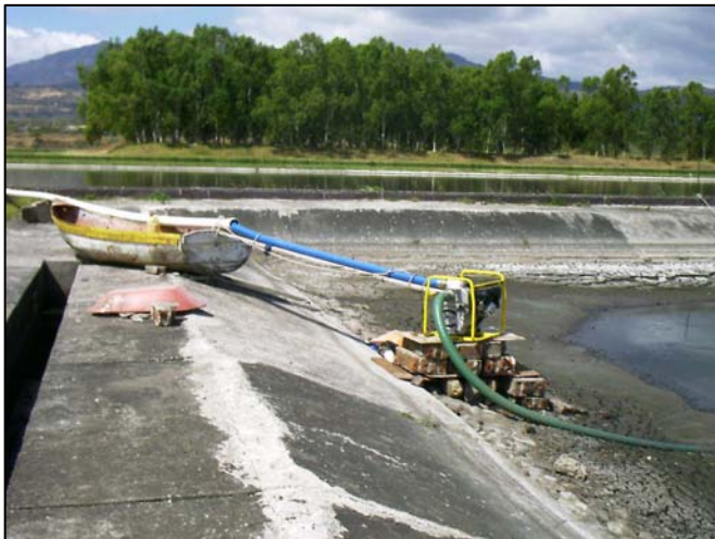
Figura 4 – Extracción de agua por bombeo de laguna secundaria “A”
