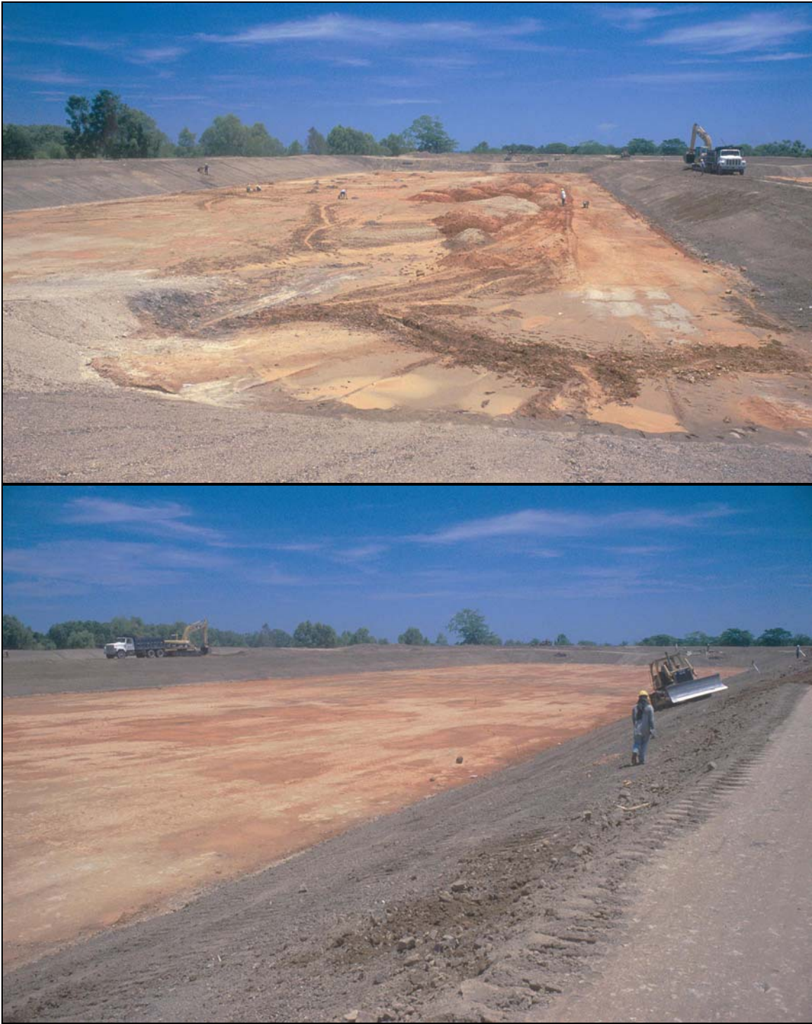
Fotos 5-5: La impermeabilización de lagunas con arcilla es fundamental para poder mantener el balance hídrico y evitar infiltración excesiva con la posible contaminación del agua subterránea. La arcilla debe ser puesta en capas con un espesor total de, por los menos, 5 a 10 cm, y cubierta con una capa de suelo para protegerla. En este ejemplo el contratista no puso arcilla en los taludes interiores y las lagunas tenían infiltración excesiva como se ve en las Fotos 5-4 (La Ceiba, Honduras).
