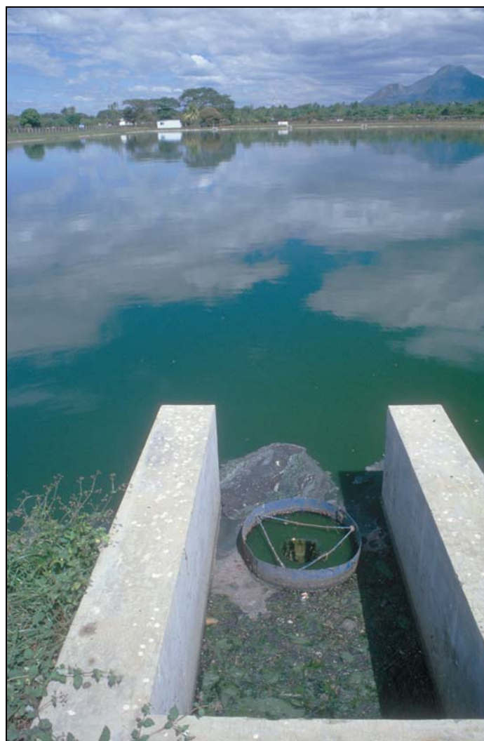
Fotos 6-6: En la foto a la izquierda, la salida de una laguna facultativa diseñada con una compuerta de fondo y un vertedero rectangular no tenía la compuerta y como resultado, los sólidos flotantes estaban saliendo con el efluente y la eficiencia de remoción de \text{DBO}_5 y coliformes fecales estaba baja (Catacamas, Honduras). La foto a la derecha muestra una pantalla circular utilizada para controlar la salida de natas en el efluente de una laguna facultativa (Chinendega, Nicaragua).
