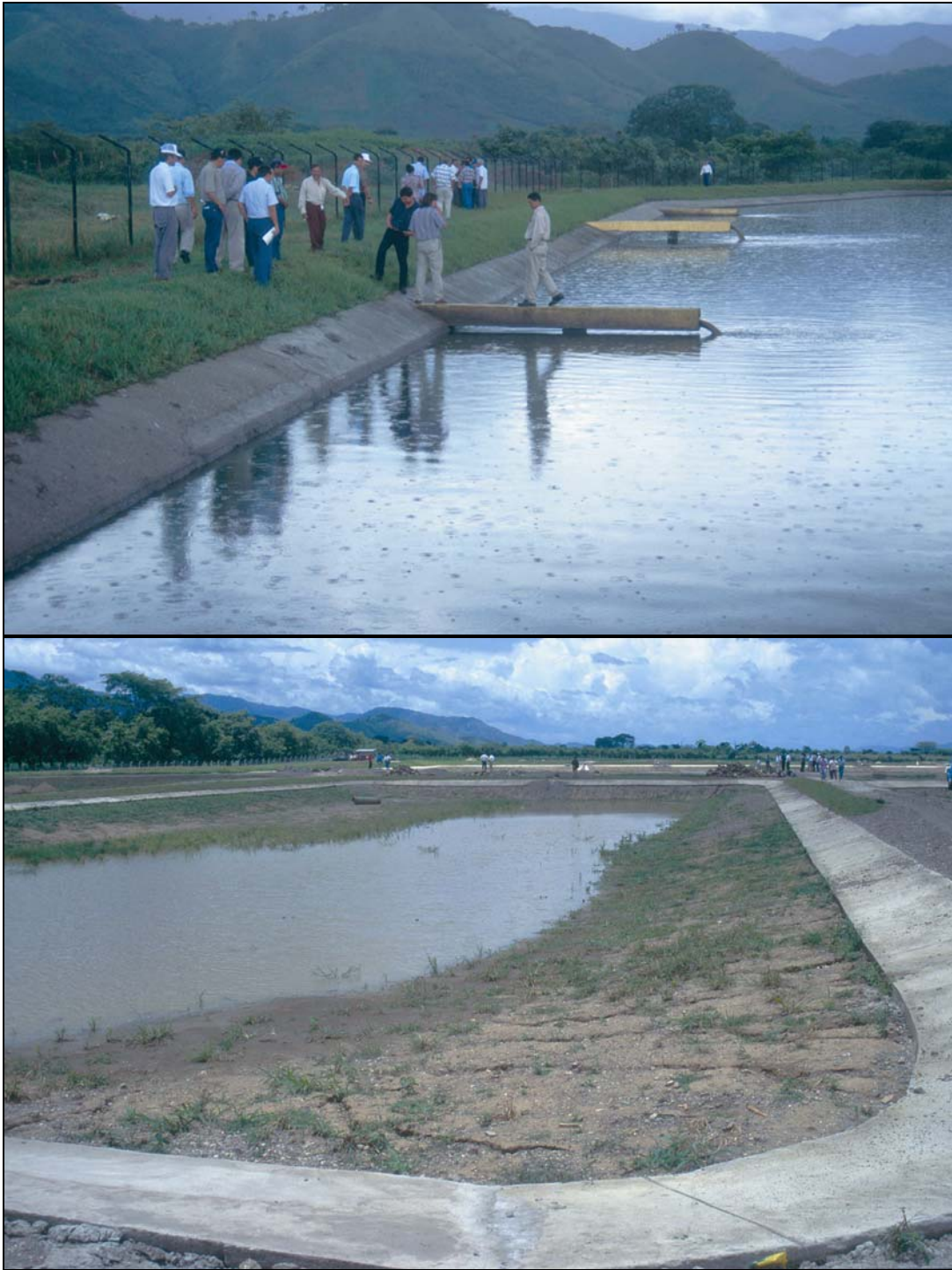
Fotos 5-19: Ejemplos de revestimientos bien contruidos. La foto de arriba (Catacamas, Honduras) es el nuevo revestimiento construido para la laguna con el mal revestimiento mostrado en la foto anterior después de una rehabilitación. La foto de abajo muestra un revestimiento bien construido para una laguna de maduración (Catacamas, Honduras).
