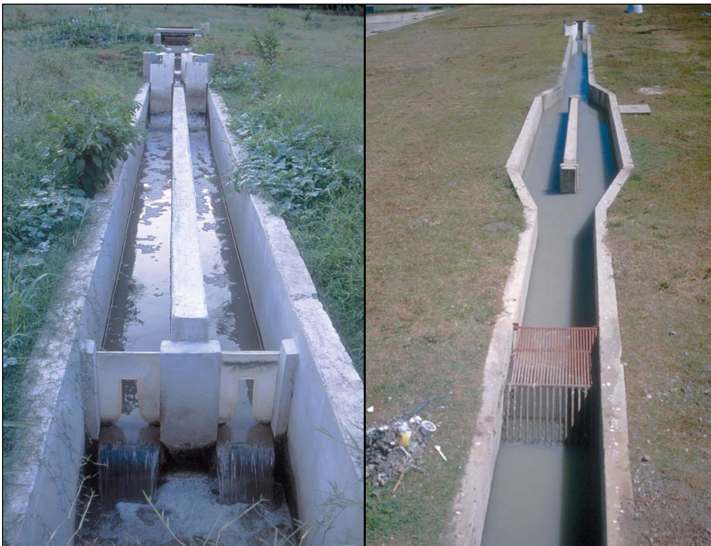
Fotos 6-2: En la mayoría de las instalaciones que cuentan con desarenadores, los operadores no están operando correctamente el desarenador, como se ve en estas fotos. Parte del problema es el mal diseño o mala construcción del desarenador donde no se puede sellar ni drenar las cámaras, y en parte es un problema de capacitación del operador en la operación correcta de desarenadores. En la foto a la izquierda (Trinidad, Honduras), el operador dejó las dos cámaras en operación por falta de una manera de sellar y drenar las cámaras. En la foto a la derecha (Granada, Nicaragua) no existían compuertas para cerrar las cámaras ni una manera de drenarlas.
