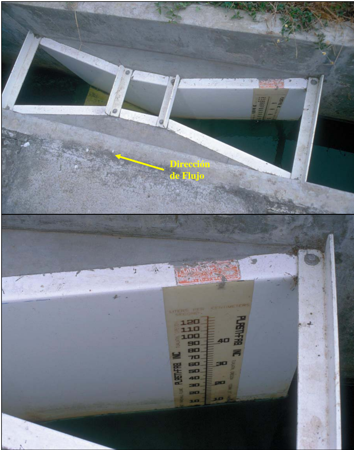
Fotos 10: Un ejemplo de una canaleta Parshall prefabricada instalada en un sistema de lagunas. El diseñador siempre debe requerir canaletas Parshall prefabricadas en el diseño y nunca canaletas Parshall hechas de concreto por los problemas de construcción y calibración como se muestran en las Fotos 12 y 13 adelante (Masaya, Nicaragua).
