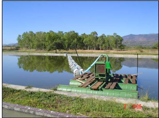
Figuras 13 –Manguera de impulsión sobre el agua
