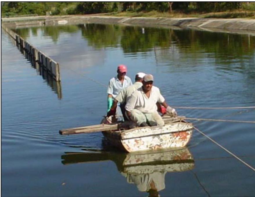
Figura 3 – Operadores movilizándose en una laguna para medir la altura de lodos
