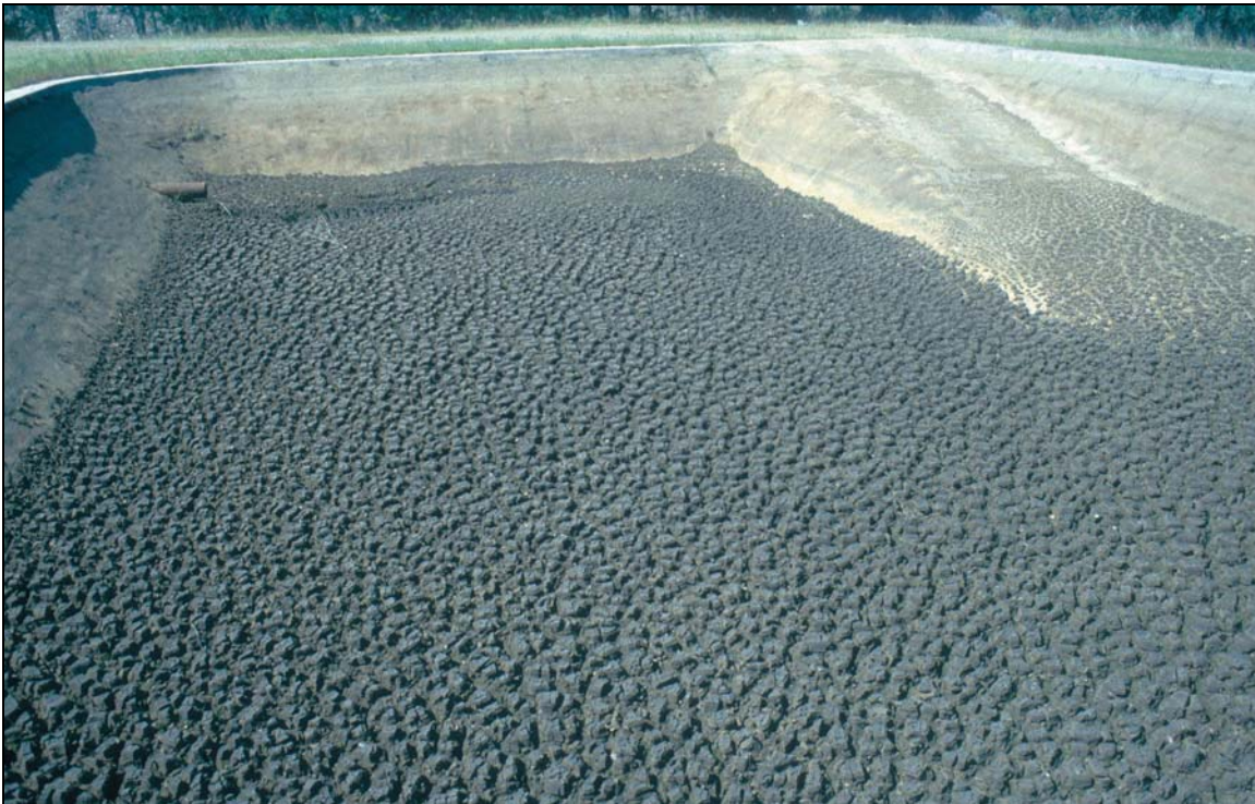
Foto 7-3: Un buen ejemplo de una laguna primaria con los lodos secos después de ser esparcidos y volteados periódicamente para facilitar el secado. Nótese la rampa para el acceso de equipo pesado (Oroville, California, EE.UU.).
