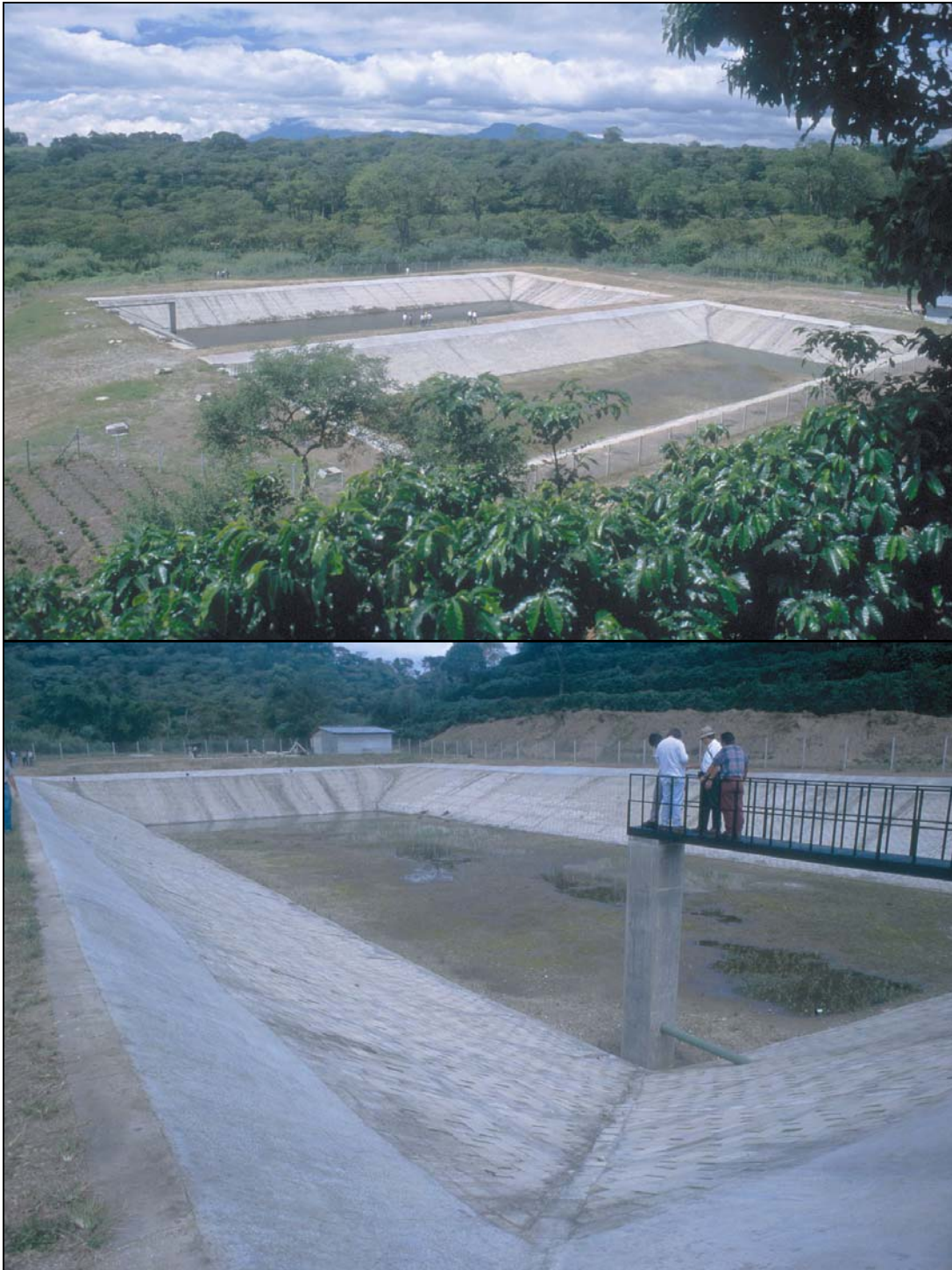
Fotos 3-1: Dos lagunas anaeróbicas en paralelo diseñadas en Boca del Monte, Guatemala. La profundidad de 4 m es típica de lagunas anaeróbicas. El problema fundamental es la dificultad de remover los lodos cuando sea necesario: normalmente, por su profundidad, los lodos tienen que ser removidos mojados por bomba o draga, lo que es mucho más costoso que remoción por secado, como se presenta en la sección 7. Nótese el dispositivo de drenaje en la foto de abajo.
