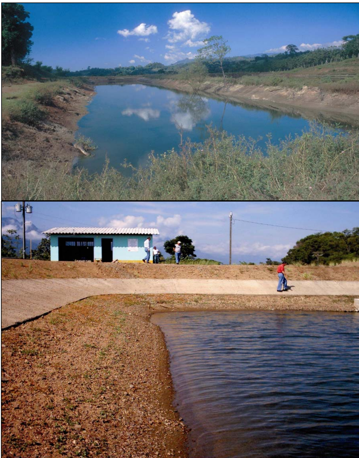
Fotos 5-4: Ejemplos de la importancia del balance hídrico. En las dos fotos las pérdidas por infiltración son excesivas y no se puede mantener el nivel del agua en las lagunas. En las dos lagunas falta impermeabilización adecuada de arcilla (Arriba: Zaragoza, El Salvador; abajo: La Ceiba, Honduras. Foto abajo cortesía de Ing. Iván Olivieri).
