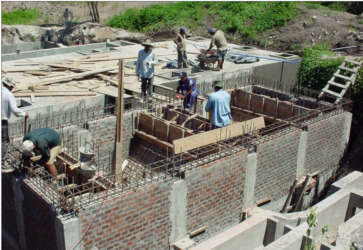
Fotografías mostrando la parte superior de RAFA´s en su etapa de construcción.
