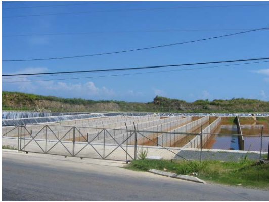
Figura 3. Celdas de deposición con deflectores, Roatán.
