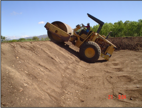
Figuras 10 – Construcción de estanque o lagunas para lodos
