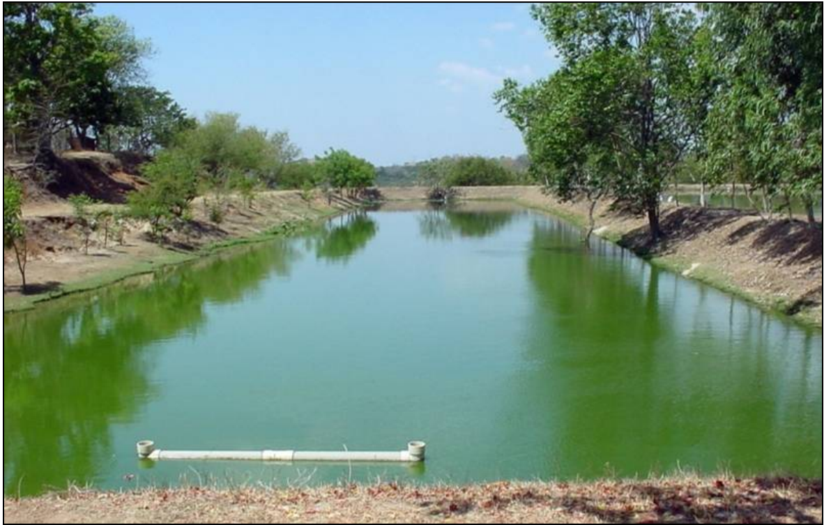
Laguna de maduración para la ciudad de Zaragoza, Depto. de La Libertad (Construida en el año de 1982).
