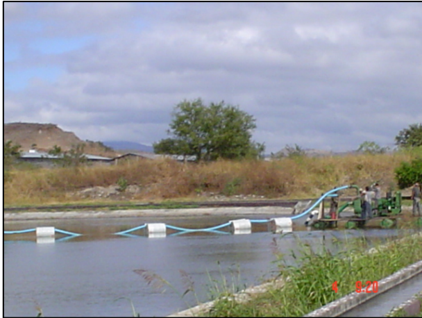
Figuras 13 –Manguera de impulsión sobre el agua
