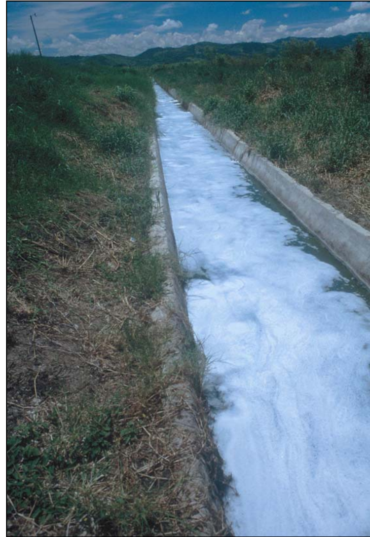
Fotos 5-15: Un ejemplo de la espuma que puede ser formada por la turbulencia cuando la descarga final está arriba del nivel del agua en el cuerpo receptor. La espuma es causada por los detergentes y otros tensoactivos no biodegradables en las aguas residuales. La manera de controlar la producción de espuma es utilizar dispositivos de descarga abajo del nivel del agua como se presenta en la Figura 5-5 (Villanueva, Honduras).
