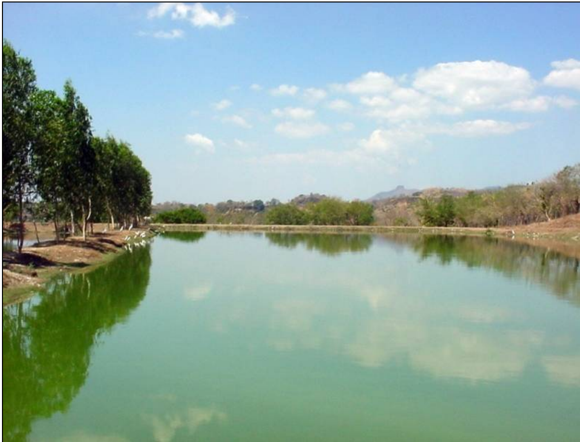
Laguna de Oxidación facultativa para la ciudad de Zaragoza, Depto. de La Libertad (Construida en el año de 1982).
