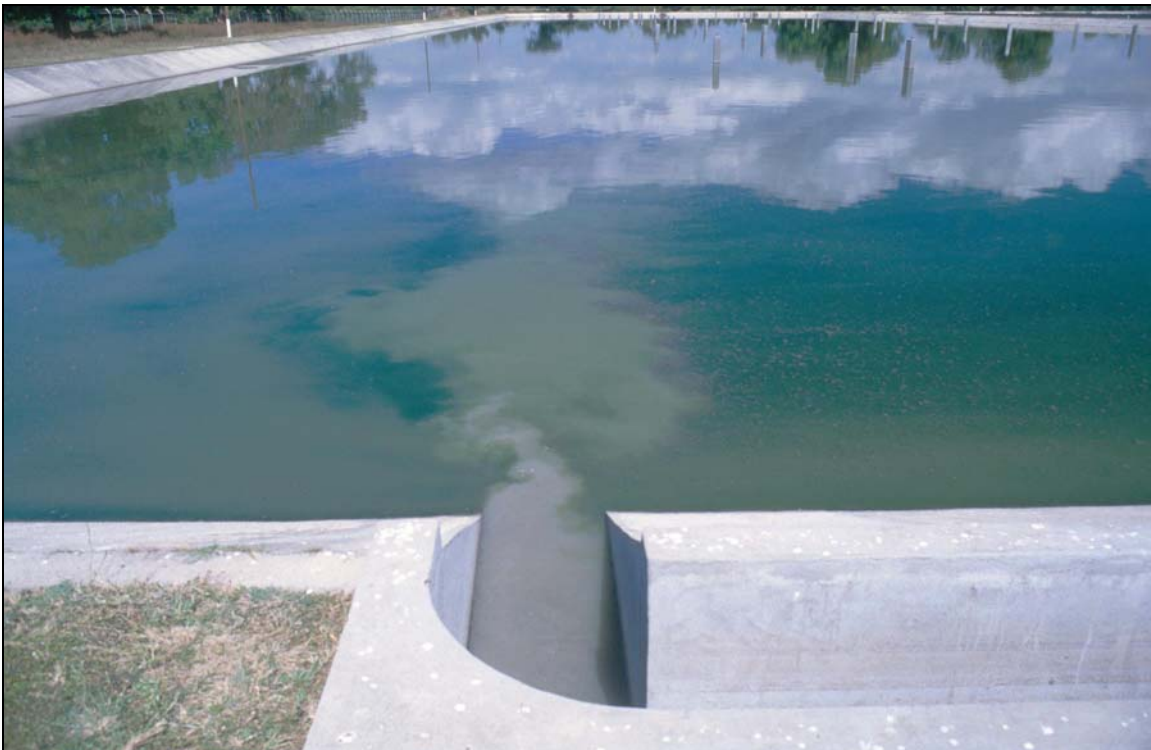
Foto 5-9: Un buen ejemplo de una entrada con el canal abierto que entra a la laguna facultativa al nivel del agua. Se ve claramente que la pluma de aguas residuales crudas que entra a la laguna está aproximándose al flujo de tipo pistón (Granada, Nicaragua).
