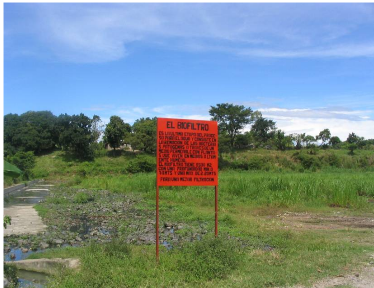
Humedales construidos, El Salvador.
