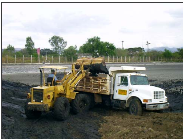
Figura 7 – Retirando lodos de la laguna primaria “A”
