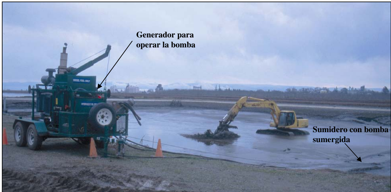
Fotos 7-5a: Un ejemplo del secado parcial con empuje por una excavadora y bombeo con una bomba sumergida de desplazamiento positivo. La bomba fue colocada en un sumidero construido por el contratista y los lodos bombeados a un lecho de secado al lado de laguna primaria (Véase las fotos seguidas). La excavadora solamente está empujando los lodos hacia el pozo de bombeo (Municipalidad de Biggs, California).
