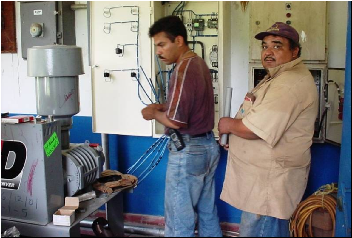
Instalación de equipos de aeración en planta de tratamiento “Chilama”.
