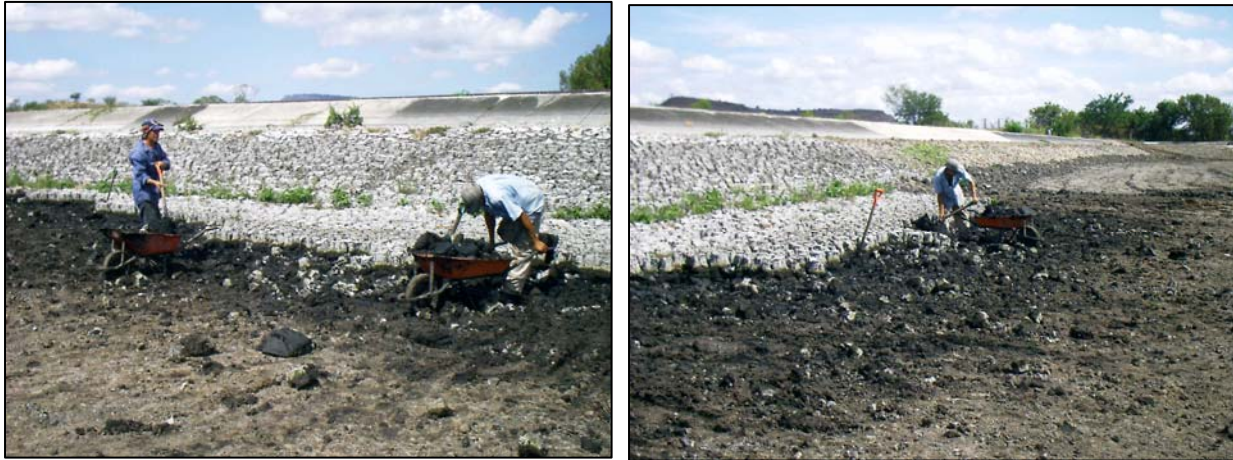
Figuras 8 – Cargando lodos con carretilla y pala en laguna secundaria “A”
