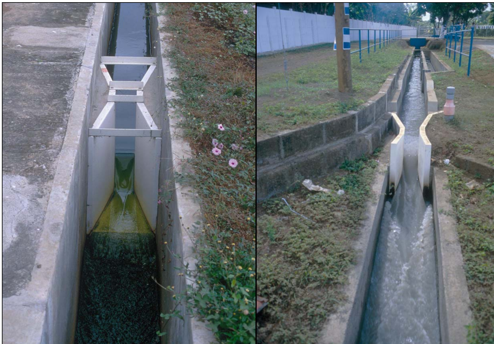
Fotos 11: Ejemplos de canaletas Parshall prefabricadas con flujo libre. Para tener flujo libre, el canal aguas abajo de la canaleta Parshall tiene que tener suficiente pendiente para que su carga máxima sea \leq 0.60 la carga máxima en el canal del desarenador medida con referencia a la base de la canaleta Parshall (Foto izquierda: León, Nicaragua; derecha: Masaya, Nicaragua).
