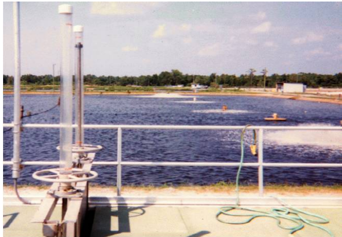
Figura 8. Reservorio de Mezcla Completa , N. Myrtle Beach, SC.
