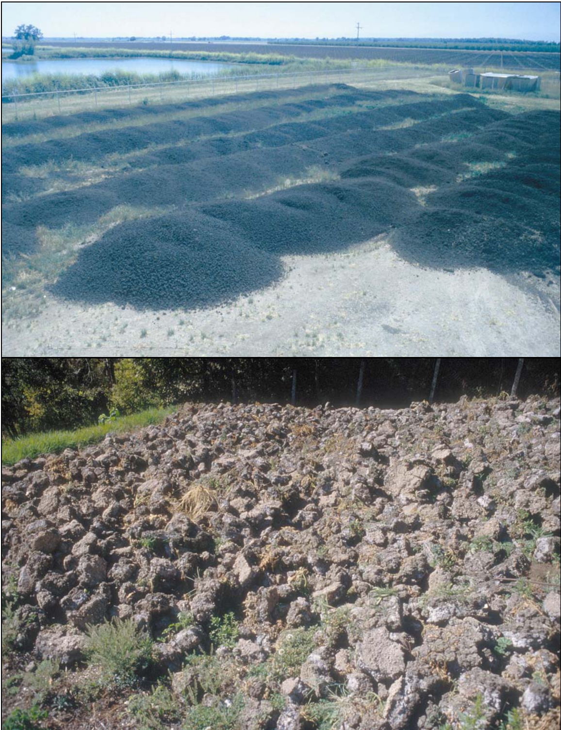
Fotos 7-4: Ejemplos de lodos secos que están almacenados en zonas especiales reservados para ellos en las plantas de tratamiento de aguas residuales. Por el riesgo de los huevos de helmintos, los lodos deben ser almacenados por lo menos un año y, antes de cualquier uso o disposición final, analizados por huevos viables de helmintos. (Foto de arriba: Planta de tratamiento de Chico, California, EE.UU.; abajo: Planta de tratamiento de San Juan Comalapa, Guatemala).
