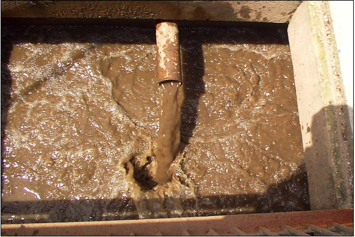
Retorno de lodos en una de la plantas de tratamiento de lodos activados.
