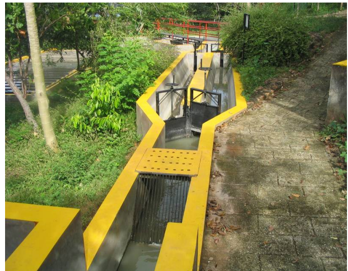
Obras de toma, Suchitoto, El Salvador.
