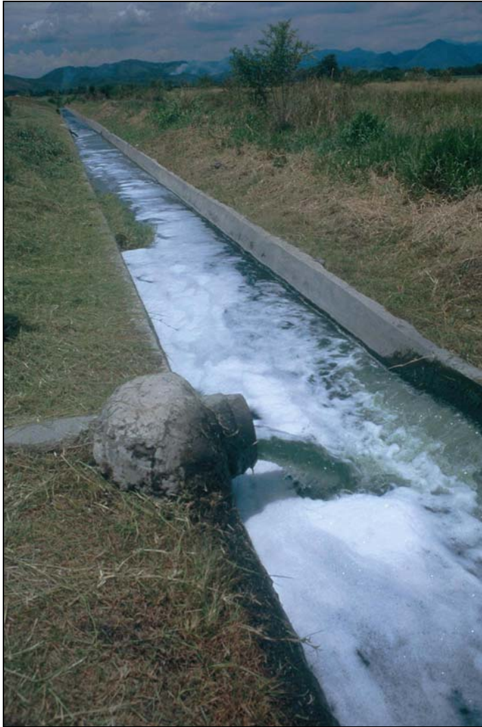
Fotos 5-15: Un ejemplo de la espuma que puede ser formada por la turbulencia cuando la descarga final está arriba del nivel del agua en el cuerpo receptor. La espuma es causada por los detergentes y otros tensoactivos no biodegradables en las aguas residuales. La manera de controlar la producción de espuma es utilizar dispositivos de descarga abajo del nivel del agua como se presenta en la Figura 5-5 (Villanueva, Honduras).
