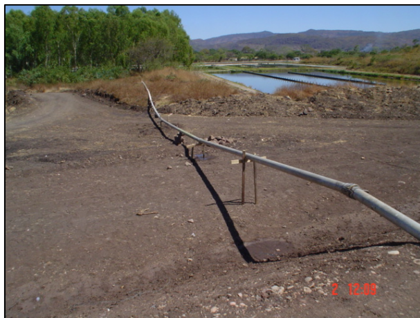
Figura 14 – Tubería de impulsión
