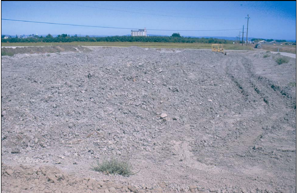
Fotos 7-5b: El lecho de secado recibiendo los lodos bombeados de la laguna primaria (foto de arriba) y los lodos dos meses después de secar (foto de abajo). El lecho de secado fue construido con un drenaje para los lixiviados, lo que llevaba los lixiviados a la otra laguna en operación. Después de secar los lodos fueron llevados a un relleno sanitario. (Biggs, California).
