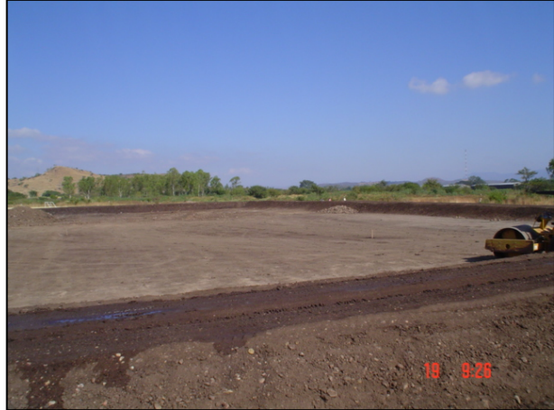
Figuras 10 – Construcción de estanque o lagunas para lodos
