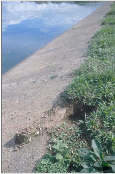
Fotos 6-11: Las tortugas pueden excavar atrás y abajo del revestimiento para depositar sus huevos. El operador debe monitorear la condición del revestimiento de rutina cuando hay poblaciones altas de tortugas (Danlí, Honduras).
