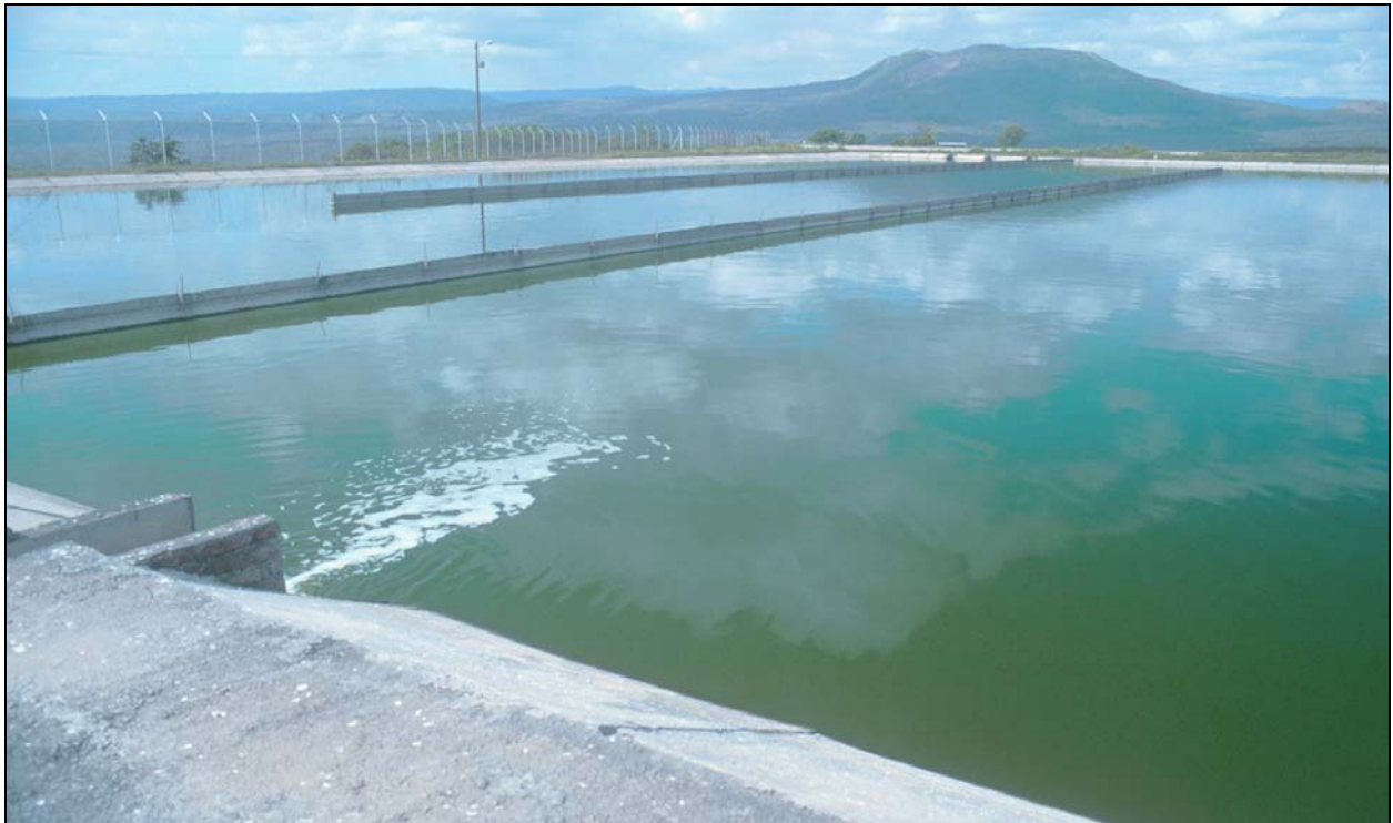
Foto 3-5: Un ejemplo de una laguna de maduración canalizada con mamparas para modelar flujo de tipo pistón. Las lagunas de maduración deben tener una relación de largo/ancho mínima de 20 a 1, y preferiblemente de 50 a 1 (Masaya, Nicaragua).
