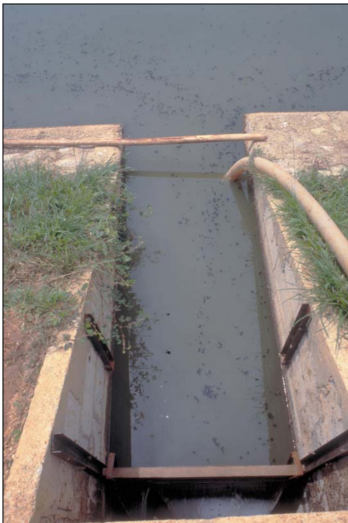
Fotos 6-6: En la foto a la izquierda, la salida de una laguna facultativa diseñada con una compuerta de fondo y un vertedero rectangular no tenía la compuerta y como resultado, los sólidos flotantes estaban saliendo con el efluente y la eficiencia de remoción de \text{DBO}_5 y coliformes fecales estaba baja (Catacamas, Honduras). La foto a la derecha muestra una pantalla circular utilizada para controlar la salida de natas en el efluente de una laguna facultativa (Chinendega, Nicaragua).
