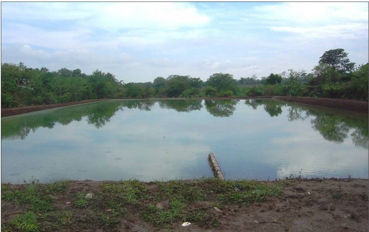
Laguna de Oxidación para la ciudad de Santiago Nonualco, Depto. de La Paz (Construida a principios de los años 70's, sólo una vez se le han extraído lodos).
