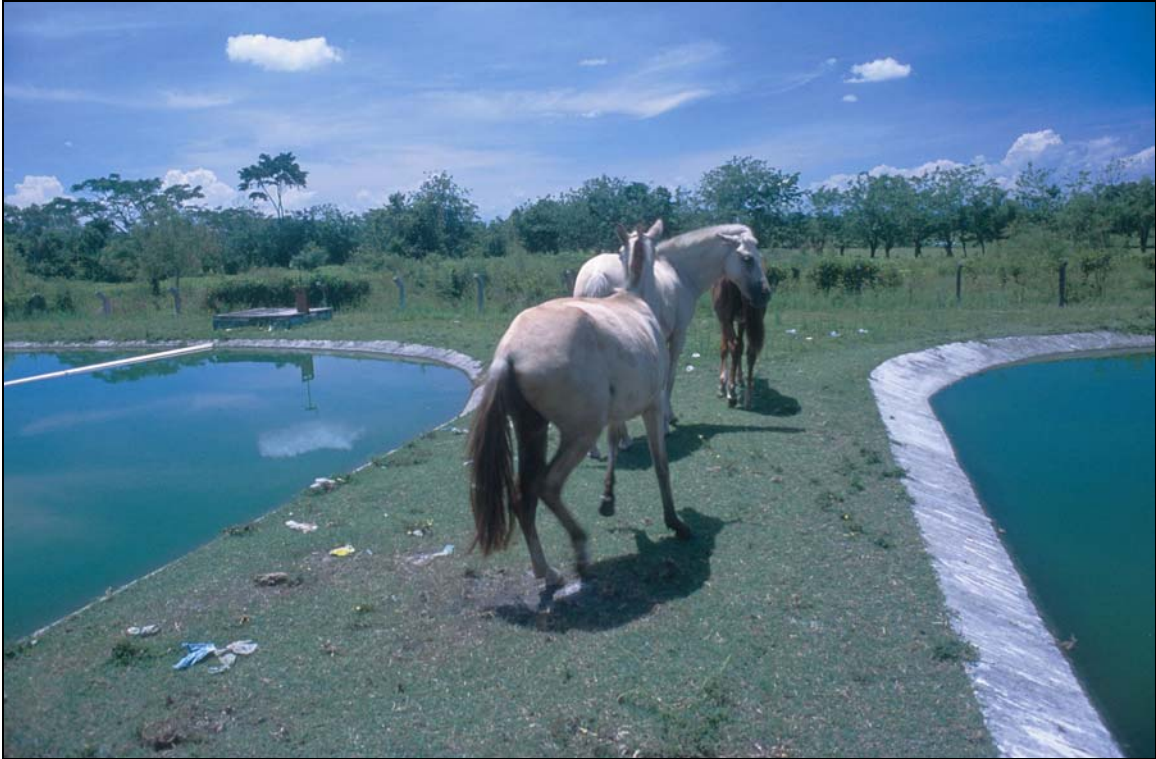
Fotos 5-21: El área que comprende la instalación de lagunas debe estar cercado, preferiblemente con alambre de púas, para prevenir la entrada de animales, que pueden dañar los taludes y servir como focos infecciosos, y la de personas no autorizadas (Foto de arriba: Tela, Honduras; Foto de abajo: Choloma, Honduras).
