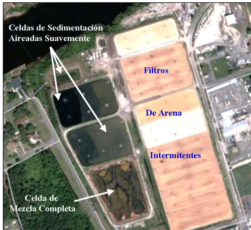
Figura 10: Vista Aérea de Planta de Tratamiento de Ocean Drive.
