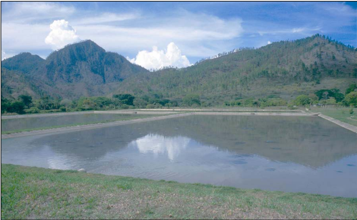
Foto 5-1: Ejemplos de sistemas de lagunas bien diseñadas y mantenidas. Los terraplenes están mantenidos con el corte de hierbas en la orilla. Los taludes interiores tienen un revestimiento de concreto o mortero que sirve para controlar el crecimiento de plantas acuáticas y evitar la erosión por acción de olas. La superficie del agua no tiene materiales flotantes ni natas, y el nivel del agua está mantenido en el centro del revestimiento(Foto arriba: Villanueva, Honduras. Foto abajo: Danlí, Honduras).
