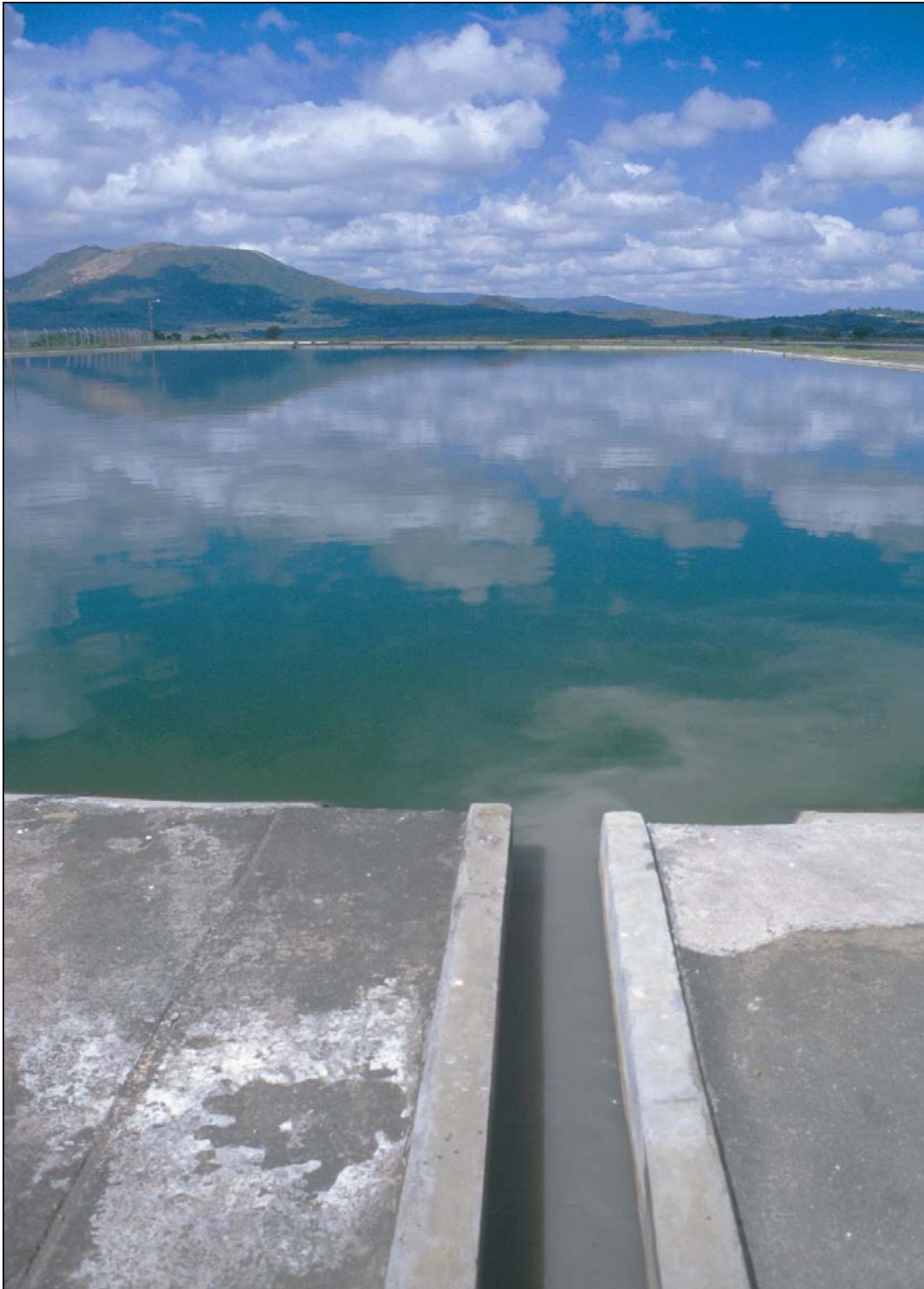
Foto 3-3: Un buen ejemplo de una laguna facultativa bien diseñada y operada. La laguna no tiene malos olores ni crecimiento de plantas acuáticas. El color verde es causado por las algas que producen oxígeno por la fotosíntesis (Masaya, Nicaragua).
