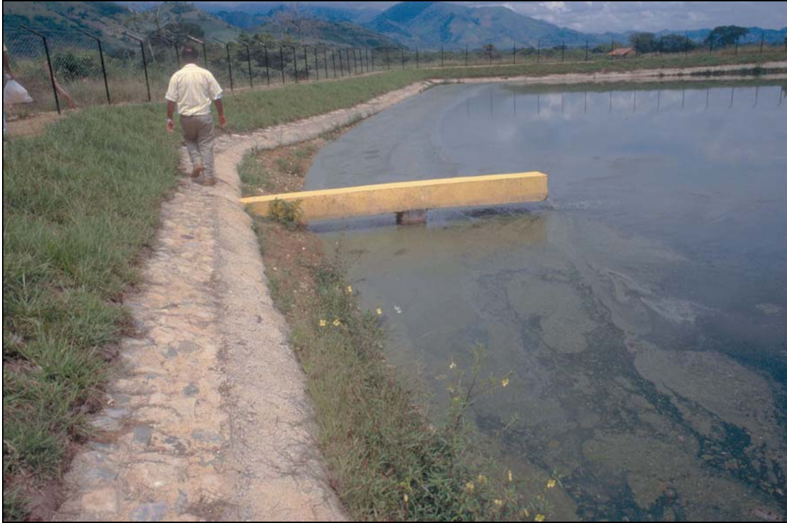
Fotos 5-18: En la foto de arriba (Tela, Honduras) la laguna facultativa tiene problemas con el crecimiento de hierbas acuáticas en la orilla por falta de un revestimiento. En la foto de abajo (Catacamas, Honduras) la deficiente construcción del revestimiento (nótese las curvas de nivel) con insuficiente borde libre no previene el crecimiento de las plantas acuáticas en la orilla.
