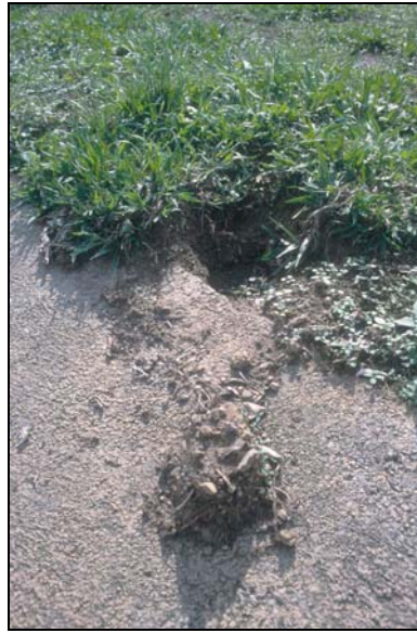
Fotos 6-11: Las tortugas pueden excavar atrás y abajo del revestimiento para depositar sus huevos. El operador debe monitorear la condición del revestimiento de rutina cuando hay poblaciones altas de tortugas (Danlí, Honduras).
