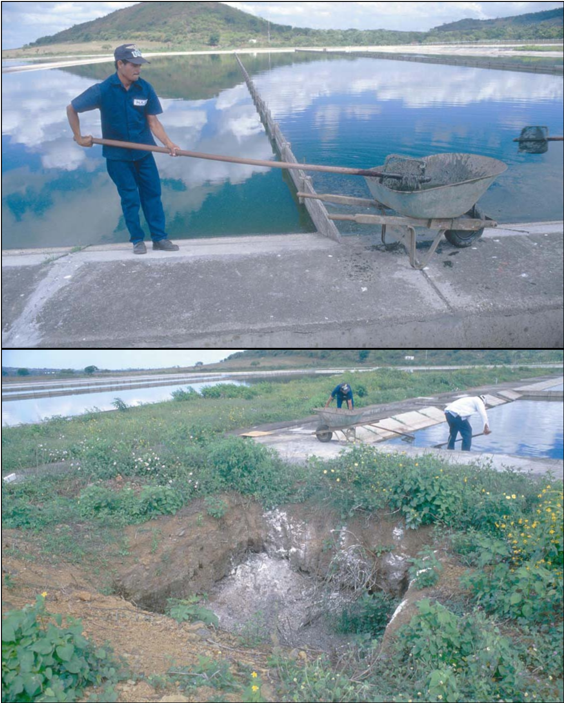
Fotos 6-5: Las natas y sólidos flotantes se acumulan en las esquinas de las lagunas, donde el operador puede sacarlos fácilmente con un desnatador y ponerlos en una carretilla. Después, se deben enterrar o cubrirlos con una capa de suelo o cal. En la foto de abajo los operadores ponen las natas recolectadas en un pozo y los cubren con cal para controlar olores. Cuando se llena la excavación se cubre con una capa de suelo (Masaya, Nicaragua).
