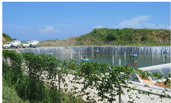
Figura 2. Primera Celda Aireada, Roatán Honduras, en construcción.
