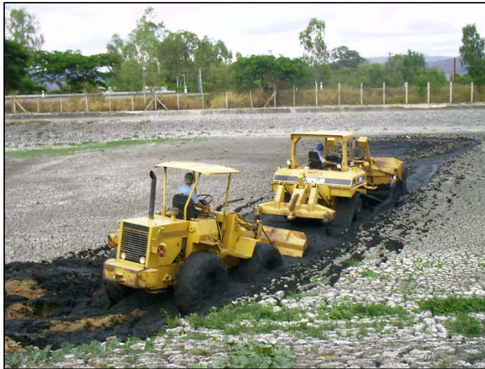
Figura 6 – Recogiendo lodos con maquinaria en la laguna primaria “A”
