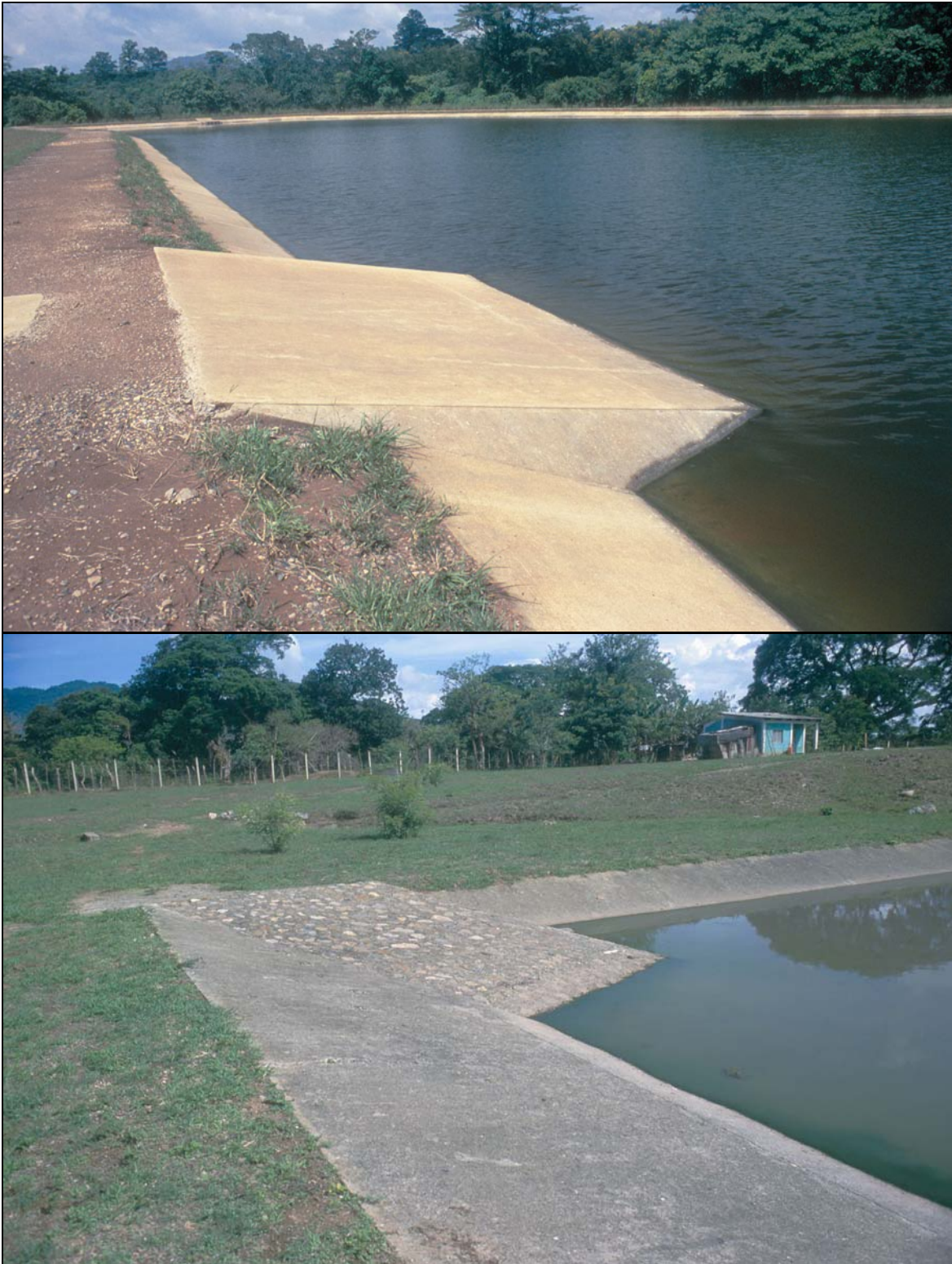
Fotos 5-20: Ejemplos de rampas de acceso en las lagunas primarias para la remoción de lodos. (Foto de arriba: laguna facultativa de Santa Cruz de Yojoa, Honduras; Foto de abajo: Laguna anaeróbica de Danlí, Honduras).
